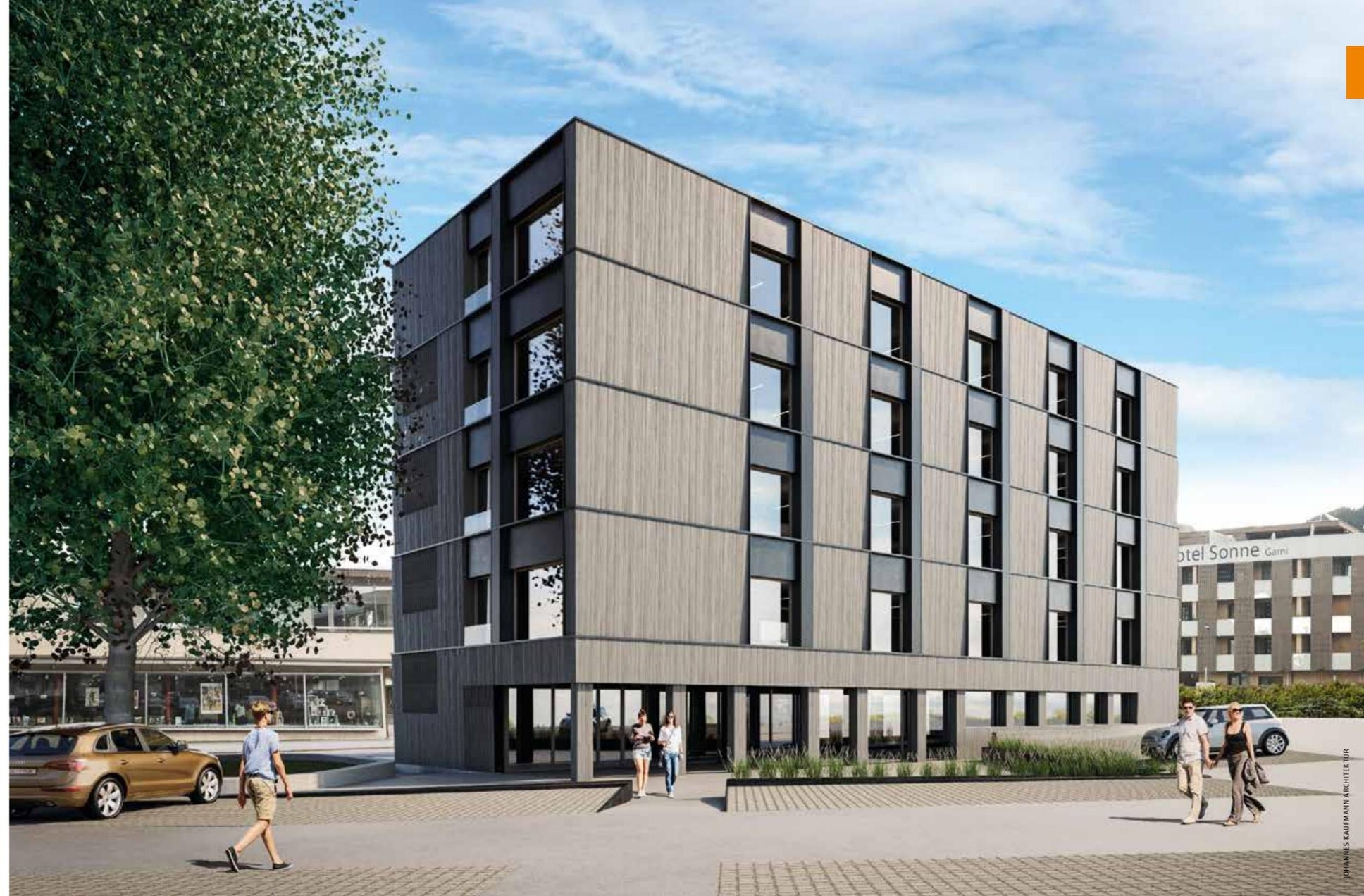
der eigenen Fichte liegt bei 100 Prozent: Was nicht in den Fassadenbau geht, wird in der Biomasseheizung zu Nahwärme verwertet bzw. zu Konstruktionsvollholz verarbeitet.
