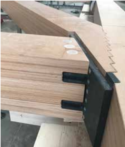
Bild 5: Zimmermannsmäßige Verbindungen ermöglichen eine ideale Kraftübertragung in den Fachwerkknoten (Foto: Susanne Jacob-Freitag)
