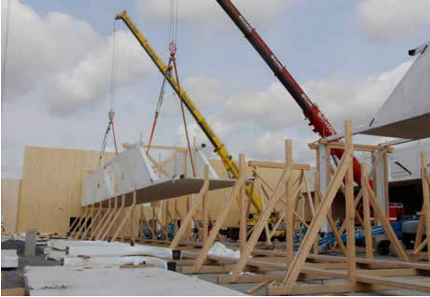
Bild 13: Anheben eines Shed-Graben-Teils. Der Shedgraben wurde mit Hilfe eines Leererüsts aus zwei Fachwerkbinder-Teilen und BSP-Platten als „Grabensohle“ auf der Baustelle zusammgebaut.
