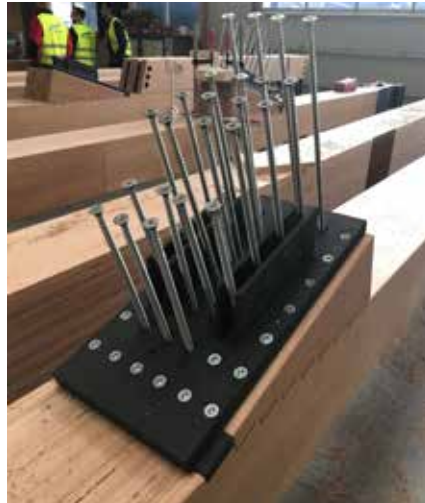
Bild 7: Die Stahlplatte wird mit speziellen Schrauben, die für BauBuche zugelassen sind, an der Knagge mit „verlängertem“ Treppenversatz befestigt (Foto: Susanne Jacob-Freitag)
