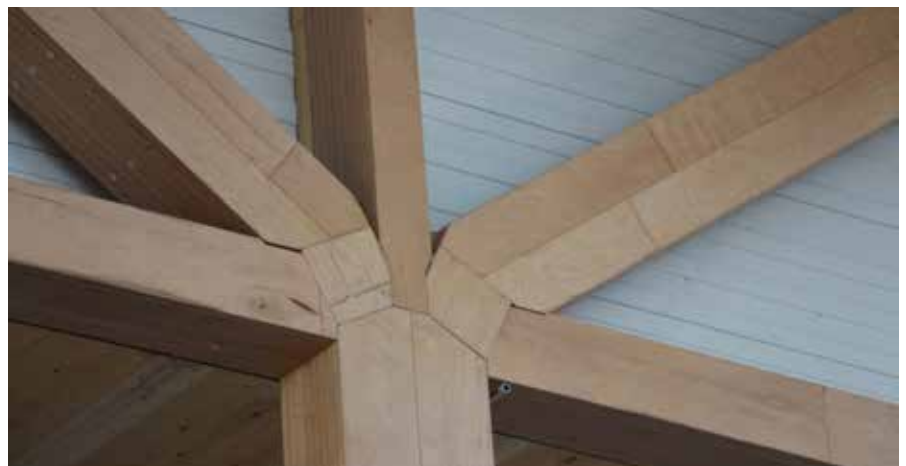
Bild 9: Die gebaute Version des „Puzzle-Knotens“ am Mittelaullager. Die Stütze muss sagenhafte Kräfte von 2,8 MN aufnehmen. (Foto: SWG Schraubenwerk Gaisbach GmbH – Geschäftsbereich Produktion)
