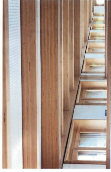
Das Tragwerk wurde in Skelettbauweise mit Stützen und Trägern aus BauBuche errichtet.
