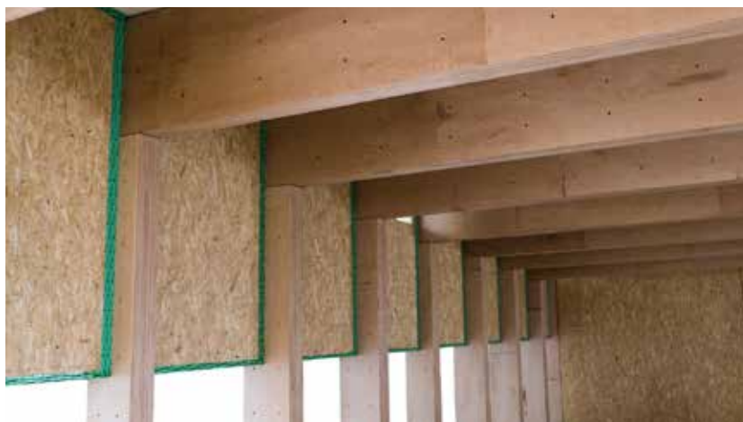
Stützen und Deckenträger bestehen aus verschraubten Buchefurnierschichtholz-Platten Fotos (2): P. Kottlorz/Kniff Projektagentur
