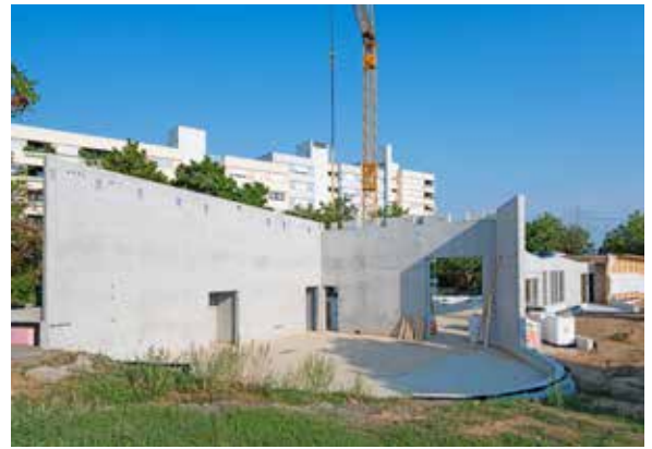
Rohbau der Mensa: Betonwände bilden das „Rückgrat“ für die hier noch fehlenden, aufgelegten Deckenträger
