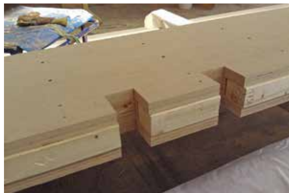
Die Zimmerer haben ein Füllholz aus KVH zwischen die oberen Furnierschichten eingelegt. So ließen sich die Deckenträger einfacher mit der Dachscheibe verschrauben Foto: Holzbau Pfeiffer
