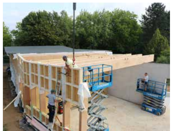
Die schlanken „Baubuche“-Deckenträger werden eingehoben und montiert Foto: Holzbau Pfeiffer
