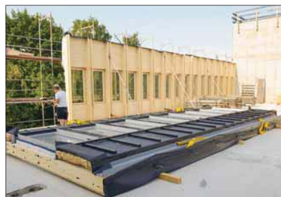
Die 10 m langen Außenwand-Elemente kommen samt Fenstern und dem kompletten Außenwandaufbau mit Unterkonstruktion und Dämmung fix und fertig auf die Baustelle.
