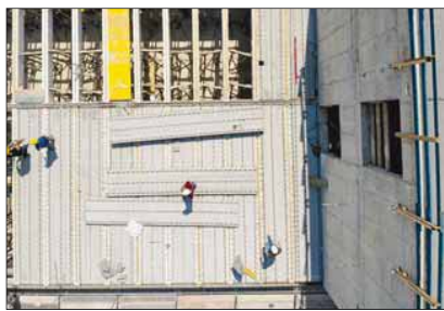
Fertigteil-Platten von 1,25 m Breite schließen die Balkenfelder. Diagonal in die Balken eingedrehte Vollgewindeschrauben sowie Zugbewehrung in den Stoßfugen verbinden Platten und Balken nach dem Vergießen mit Beton schubfest zu einer Deckenscheibe. Foto: WKI/Stephan Thiele
