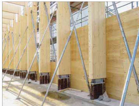
An die 15 cm hohe Aufkantung des Streifenfundaments schließt die Bewehrung für den 85 cm hohen Betonsockel an. Die spezielle Stahlkonstruktion für die Stütznivellierung wird mit einbetoniert.
