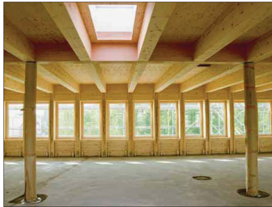
Für die Mittelstützen-Reihe im zweiten Obergeschoss kamen Rundholzstützen zum Einsatz. Für den hochbelasteten Längsträger der Mittelachse nutzten die Planer in diesem Geschoss Buchen-Furnierschichtholz anstelle eines Stahlbeton-Fertigteil-Trägers. Die Dachdecke ist eine Holzbalkendecke. Die Stützen erhielten zur Leitungsführung raumseitig zusätzlich zwei Stege.
