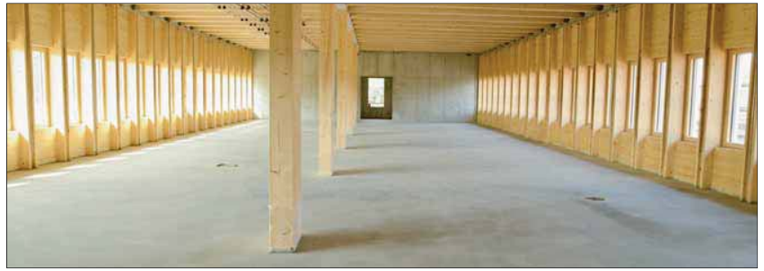
Blick ins erste Obergeschoss: Die 30 m lange Holzskelett-Konstruktion, die zwischen den Beton-Erschließungskernen eingefügt ist, hat drei Haupttragachsen: Zwei Außenwand-Achsen und eine mittlere Stützen-Achse.
