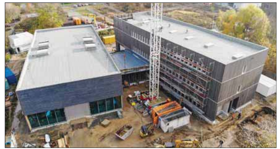
22. November 2019: Das Zeluba-Forschungszentrum steht kurz vor der Fertigstellung. Ab Herbst 2020 kann die Arbeit in dem multifunktionalen Gebäude beginnen. Fotos (2): WKI/Stephan Thiele
