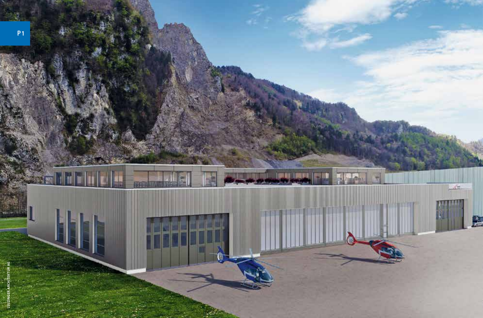
▲ Auf dem Dach der Helikopterhalle befindet sich das U-förmig angelegte Bürogeschoss
