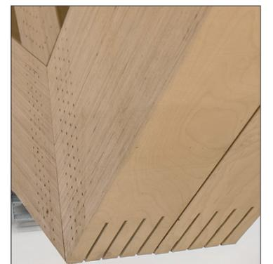
Die Fachwerk-Knoten wurden mit eingeschlitzten Blechen und selbstbohrenden Stabdübeln ausgeführt.
