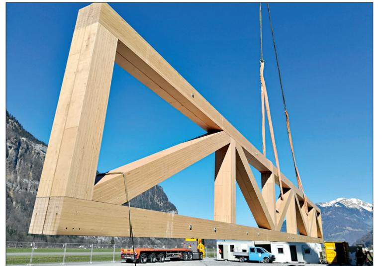
Der 30,40 m lange und 3,16 m hohe Abfang-Fachwerkträger ist in Gebäudelängsrichtung zwischen Massivbauten eingepasst und dient den 31,70 m langen Hauptbindern auf einer Seite als Auflager. Fotos: Foto Mächler AG, Galgenen
