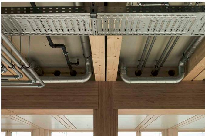
Deckenintegrierte Installationsebene mit „BauBuchen“-Tragwerk.
