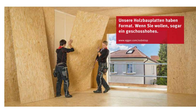
Eine raumhohe Beplankung bedeutet natürlich immer geringeren Aufwand. Zudem entstehen weniger Fugen und weniger Verschnitt als bei kleineren Plattenformaten, was wiederum Zeit und Geld spart. Wir sind sicher: Die geschosshohen OSB 4 TOP Platten überragen damit selbst die höchsten Ansprüche.
