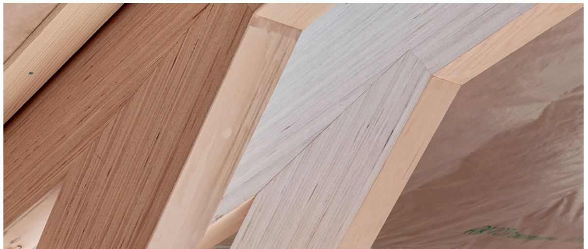
BauBuche GL75, Strebenanschluss mit einfachem Stirnversatz Projekt Tischlerei Mohr Holzbau Kaufmann Zimmerei
