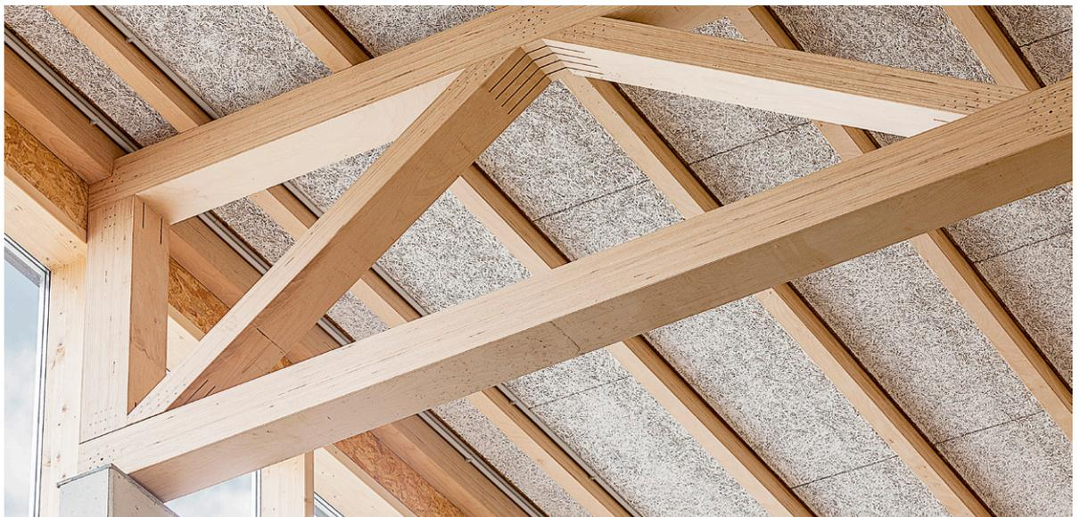
Poutres en treillis BauBuche avec assemblage BSB, i+R Holzbau
