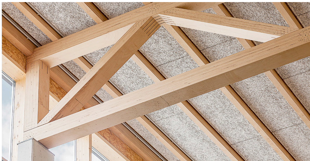
BauBuche Fachwerkträger mit BSB-Verbindung, i+R Holzbau
