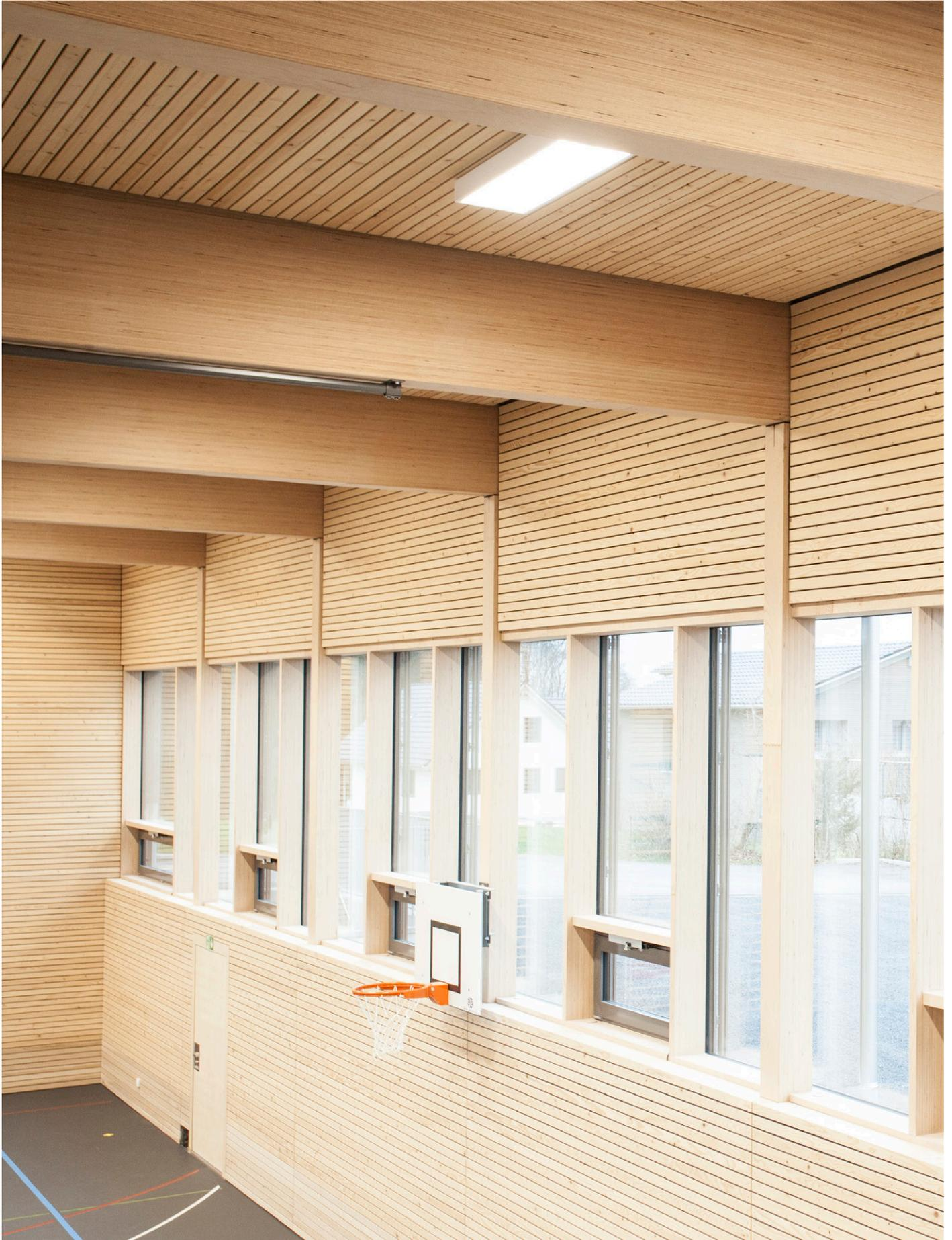
**Neubau Turnhalle, Islisberg** Schlanke Trägerhöhe mit 12,60 m Spannweite und Querschnittsabmessungen von nur 90cm Höhe und 20cm Breite. Architekten Langenegger Architekten AG, Muri Tragwerksplanung Makiol Wiederkehr AG, Beinwil am See Holzbau Max Vogelsang AG, Wohlen
