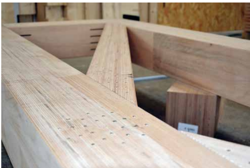
◀ Baubuche-Fachwerk mit der von I+R Holzbau favorisierten BSB-Verbindung
