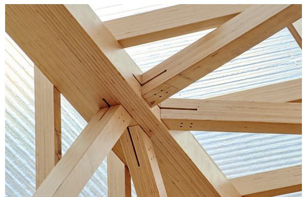
Anschlussdetail mit Stabdübel-Schlitzblechverbindung Projekt Zukunftspavillon Frankfurt Holzbau Hess Timber GmbH Fotos Rensteph Thompson, Chris Kister
