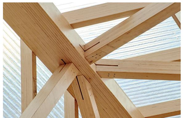
Détail de raccordement avec un assemblage cheville métallique-plaque perforée
