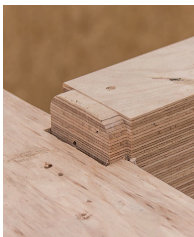
Raccordement poutre principale-poutre de rive
