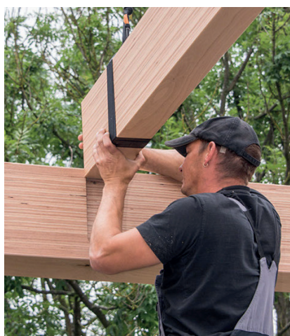
Raccordement poutre principale-poutre de rive
