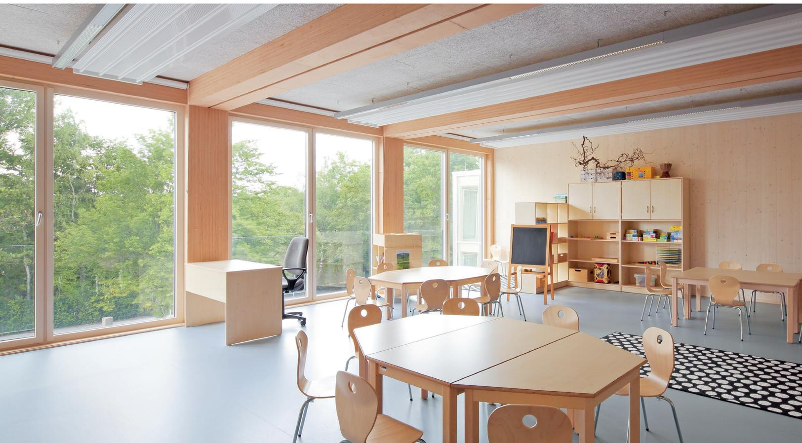
**Referenz: Europäische Schule, Frankfurt** Die Erweiterung des bestehenden Schulgebäudes wurde in modularem Holzbau errichtet. Um die Unterzüge mit möglichst schlanke Querschnitten bei hoher Festigkeit zu realisieren, wurde BauBuche GL75 eingesetzt. Das Projekt hat den Holzbaupreis Hessen 2015 erhalten.
