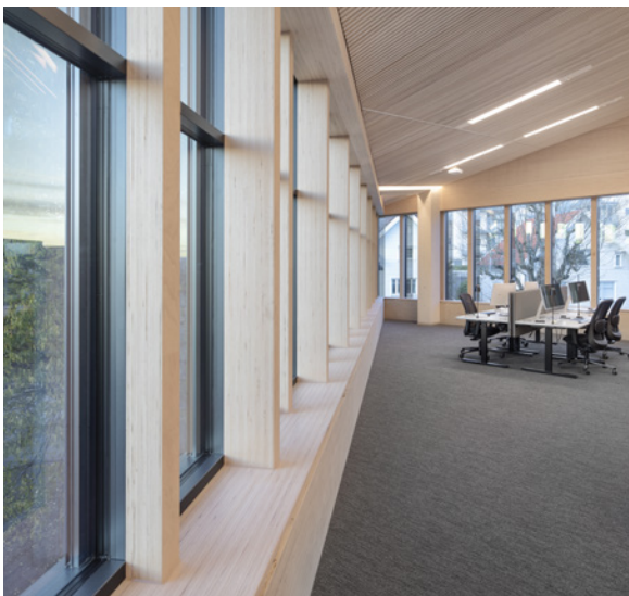
Das neue Gebäude der SR Bank besteht zu großen Teilen aus Holz, Stavanger (Norwegen) BauBuche wurde unter anderem für die Stützen im Erdgeschoss verwendet. Architekt Helen & Hard Architects in Kooperation mit SAAHA architects Holzbau Moelven
