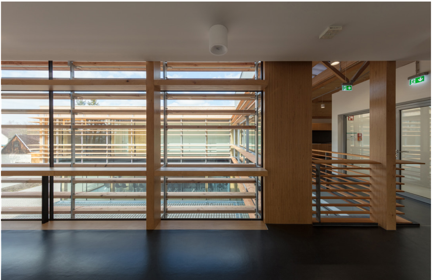
Tragskelett aus BauBuche im Forstamt Jena, Stadtroda Beim Bau des Forstamts wurde auf heimisches Holz gesetzt. Architekt cornelsen + seelinger architekten BDA Holzbau Grossmann Bau GmbH & Co. KG Tragwerksplanung merz kley partner ZT GmbH
