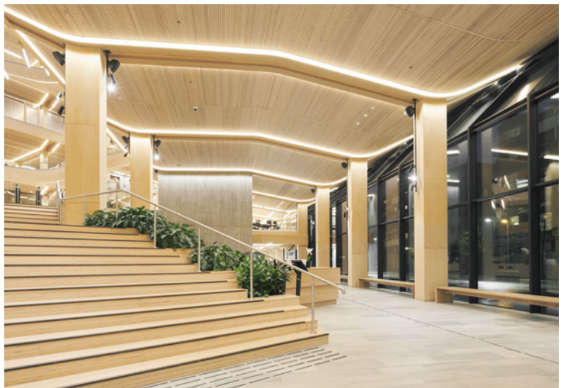
Das neue Gebäude der SR Bank besteht zu großen Teilen aus Holz, Stavanger (Norwegen) BauBuche wurde unter anderem für die Stützen im Erdgeschoss verwendet. Architekt Helen & Hard Architects in Kooperation mit SAAHA architects Holzbau Moelven
