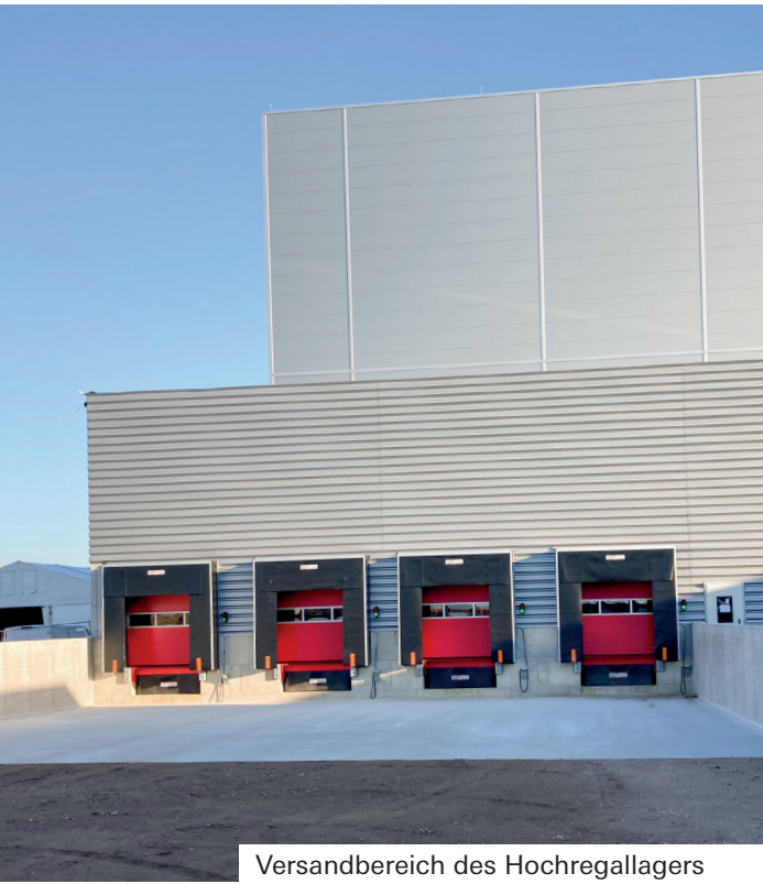
Versandbereich des Hochregallagers
