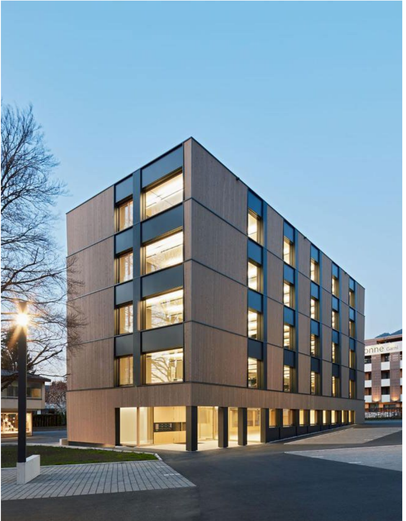
Blick von Südwesten
