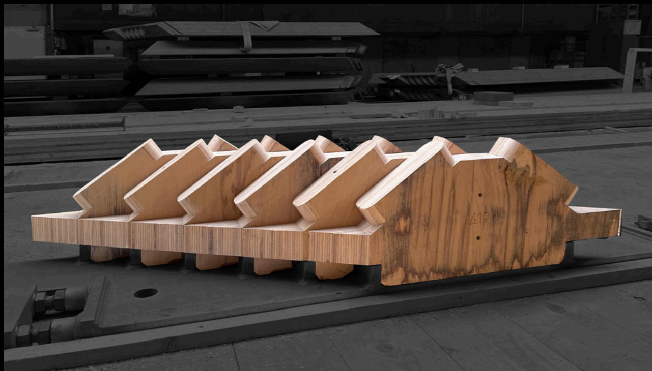
Die Verbindung der einzelnen Fachwerk-Fassadenelemente untereinander erfolgt über eine eigens entwickelte, klebstofffreie Steckverbindung.
