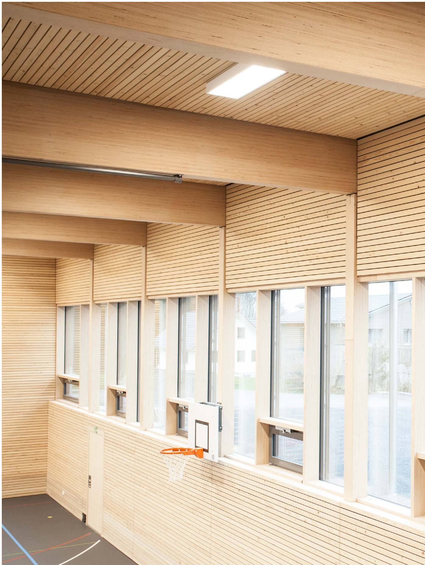
Neubau Turnhalle, Islisberg Schlanke Trägerhöhe mit 12,60m Spannweite und Querschnittsabmessungen von nur 90cm Höhe und 20cm Breite. Architekten Langenegger Architekten AG, Muri Tragwerksplanung Makiol Wiederkehr AG, Beinwil am See Holzbau Max Vogelsang AG, Wohlen
