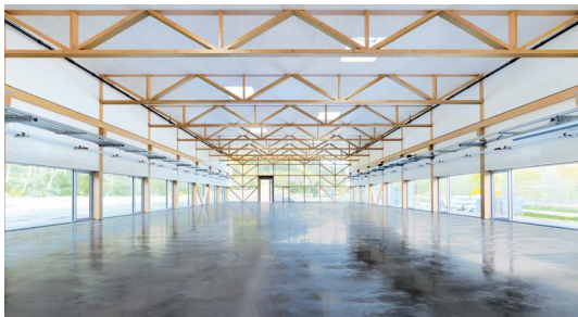
Im 21. Jahrhundert erlebt der Holzbau eine Renaissance: Halle mit Fachwerkträgern aus Holz, BauBuche, 2016
