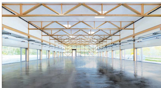
Au 21 ème siècle, la construction en bois connaît une renaissance : Hall avec poutres en treillis en bois, BauBuche, 2016
