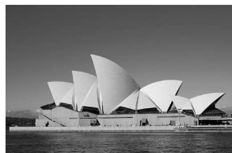
Les nouveaux matériaux supplantent très largement le bois dans le secteur de la construction. Opéra de Sydney, construction en béton armé, 1973
