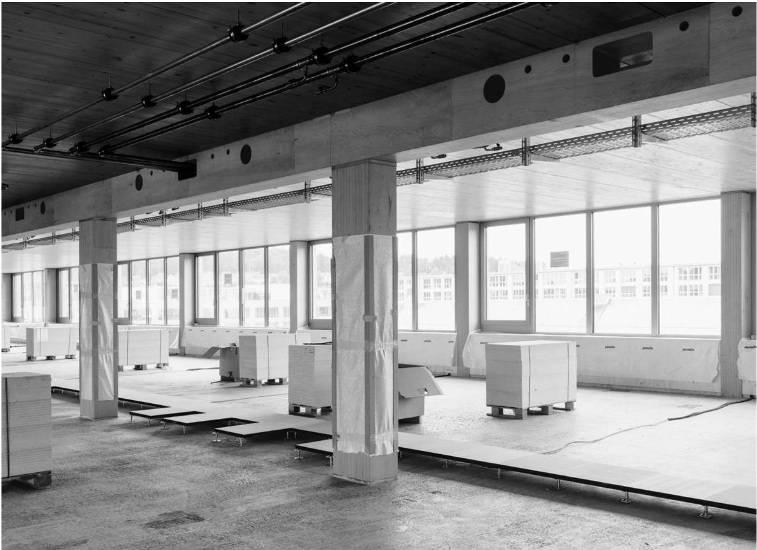
Durchbrüche > 5 cm nur über Zulassung im Einzelfall
