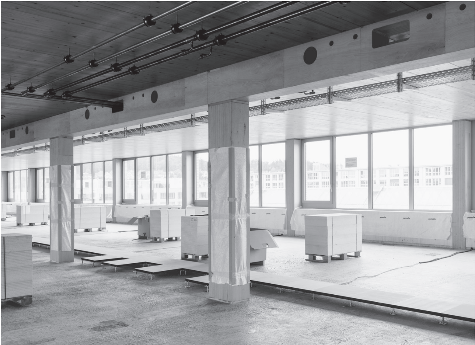
Durchbrüche > 5 cm nur über Zulassung im Einzelfall
