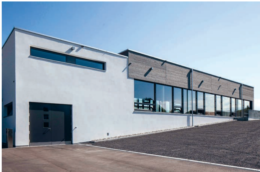
Die Vogelsang Holzbau AG aus Wohlen hat das Holztragwerk für die Sporthalle errichtet.
