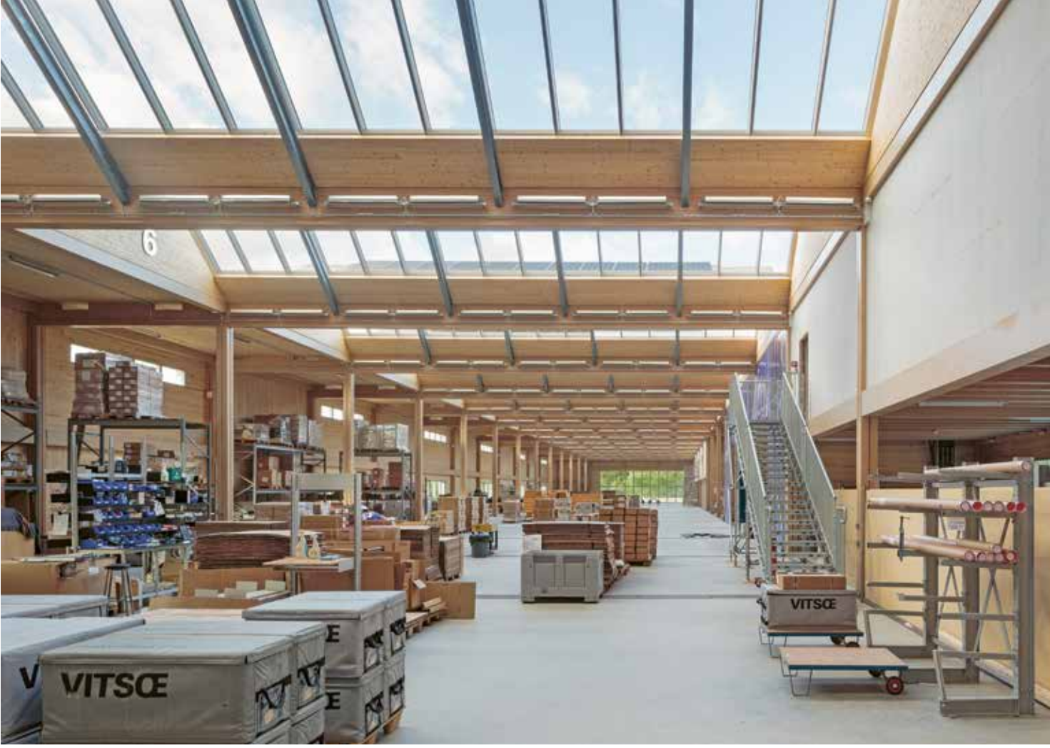
Der Blick nach Norden zeigt die Durchlässigkeit der Sheddächer mit ihrem blendfreien Zenitallicht.
